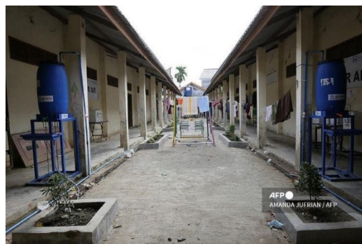
Gambar 5.2 Kondisi Huntara Pengungsi Rohingya di Aceh
