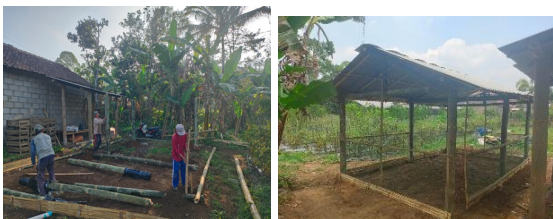
Gambar 1a. Pembuatan Pondasi Rumah Cacing, b. Rumah Cacing yang Siap Digunakan
